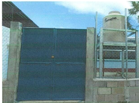
Foto 2: Área finalizada en la que se realizó el mejoramiento e instalación de un portón metálico en el lado Sur.
