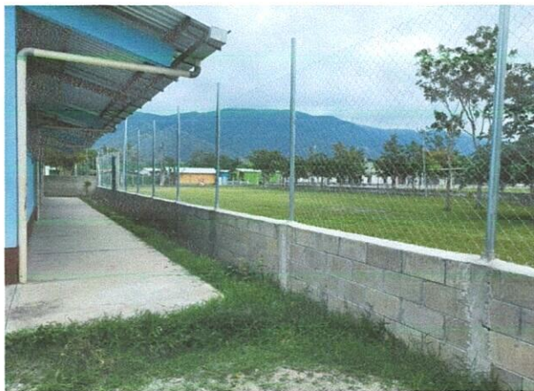
Foto 1: Área finalizada en la que se realizó el mejoramiento del cerramiento perimetral en los lados Sur y Norte.
