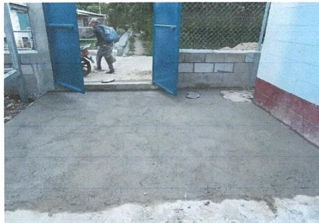
Foto 2: Área finalizada en la que se realizó el mejoramiento de la losa de patio en el lado Sur y en la entrada principal del instituto.
